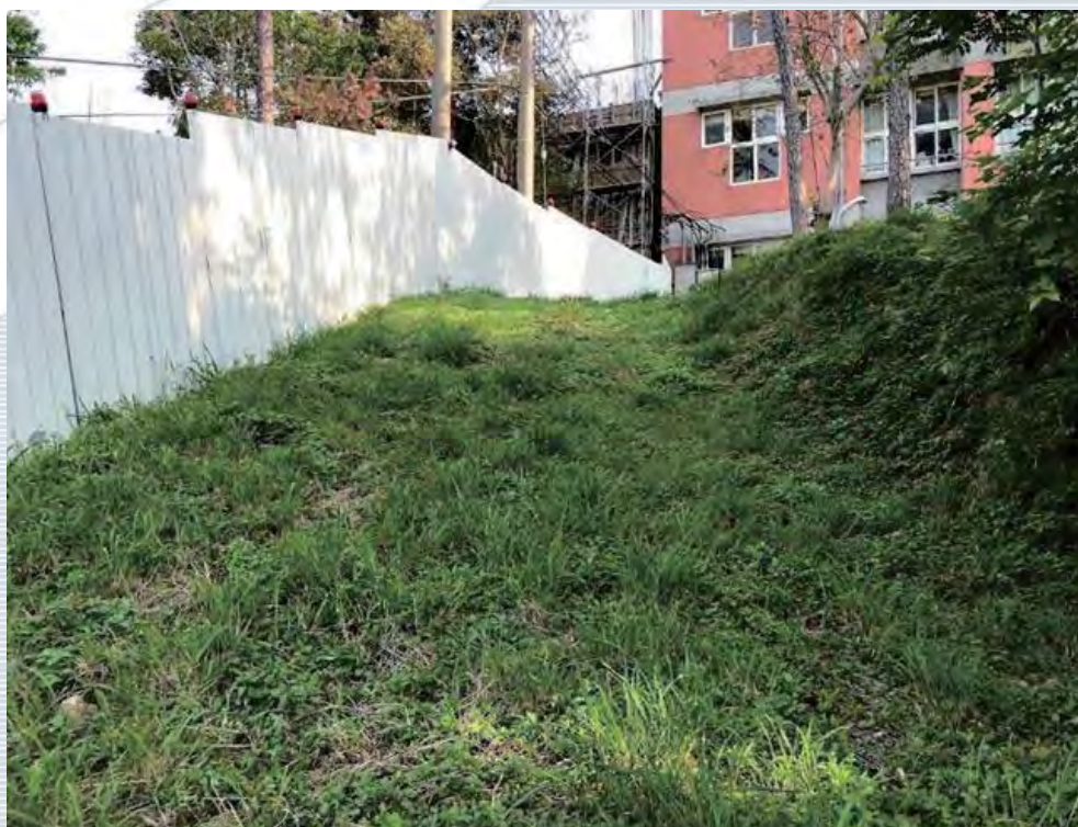
Before 陡坡原本的樣貌，險峻之處
